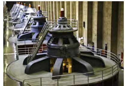
Resim 1.15. Bir hidroelektrik santralinde türbinler jeneratörü döndürür.
